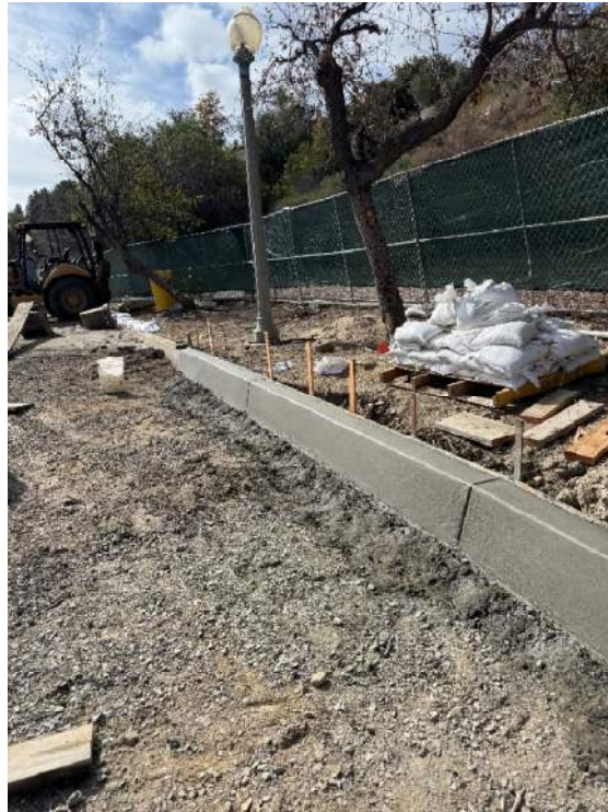
Concrete Pour for Curb & Gutters
