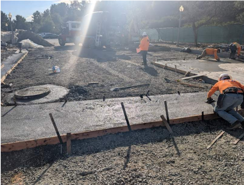
Formed & Concrete Pour Ribbon Gutters
