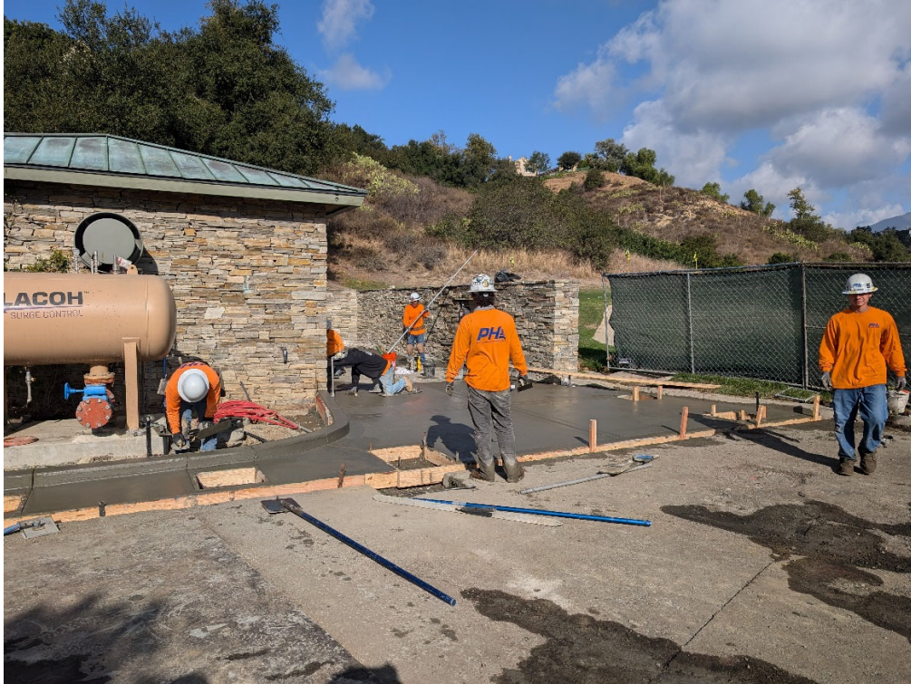
Pour & Finish Driveway Apron & Roller Gate Track
