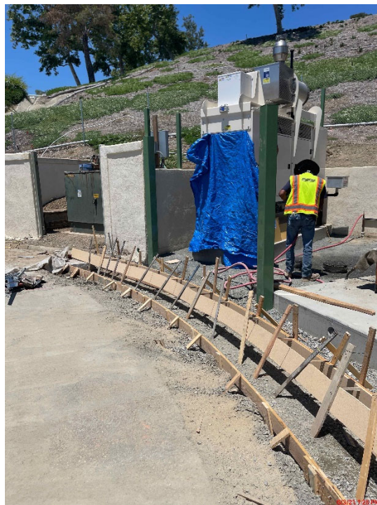
Form & Pour of Rolled (Mountable) Curb
