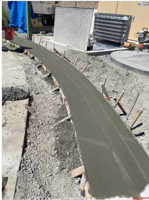
Form & Pour of Rolled (Mountable) Curb
