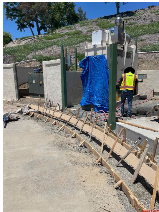
Form & Pour of Rolled (Mountable) Curb
