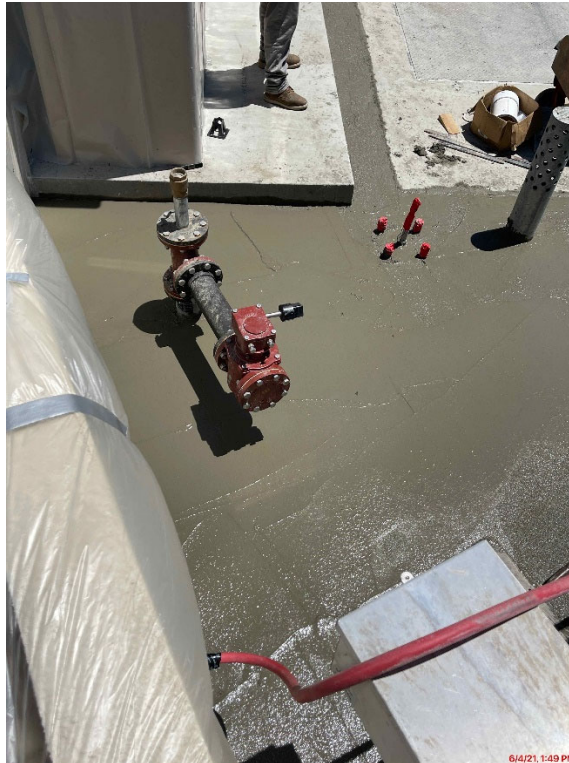
Concrete Pour of Sidewalk Areas
