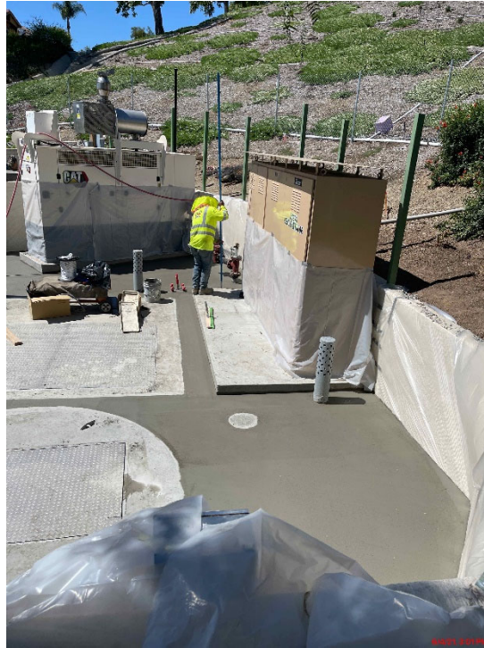
Concrete Pour of Sidewalk Areas
