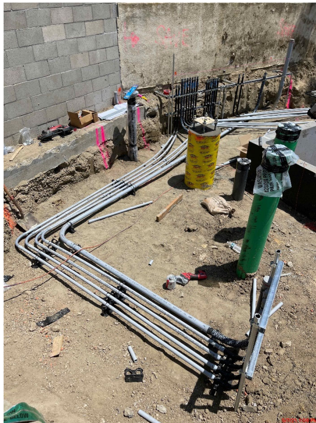
Placement of electrical conduits
