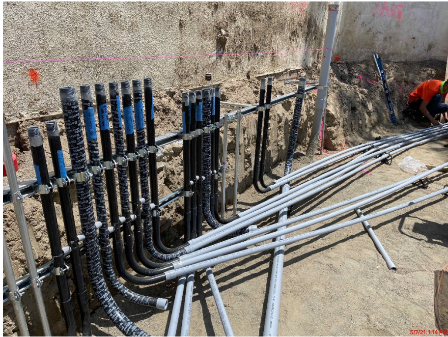
Placement of electrical conduits
