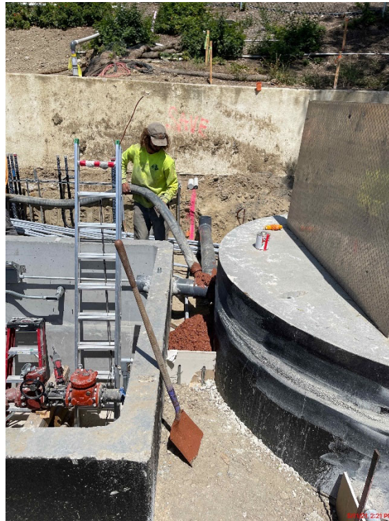
Pour concrete for electrical duct bank
