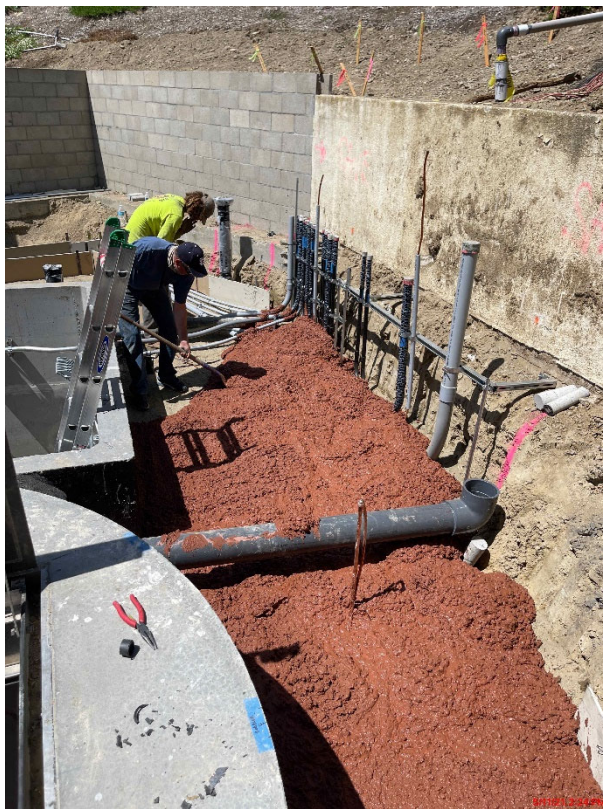
Pour concrete for electrical duct bank
