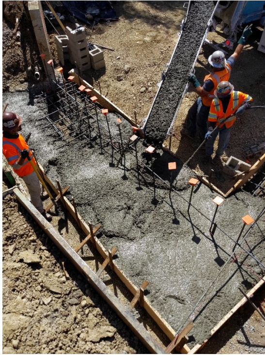
Concrete pour for Wall Footings
