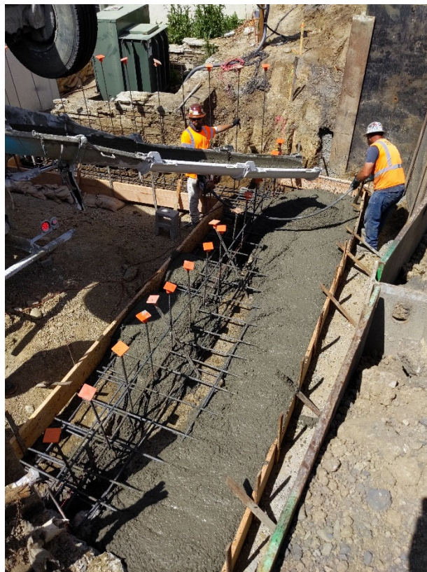
Concrete pour for Wall Footings
